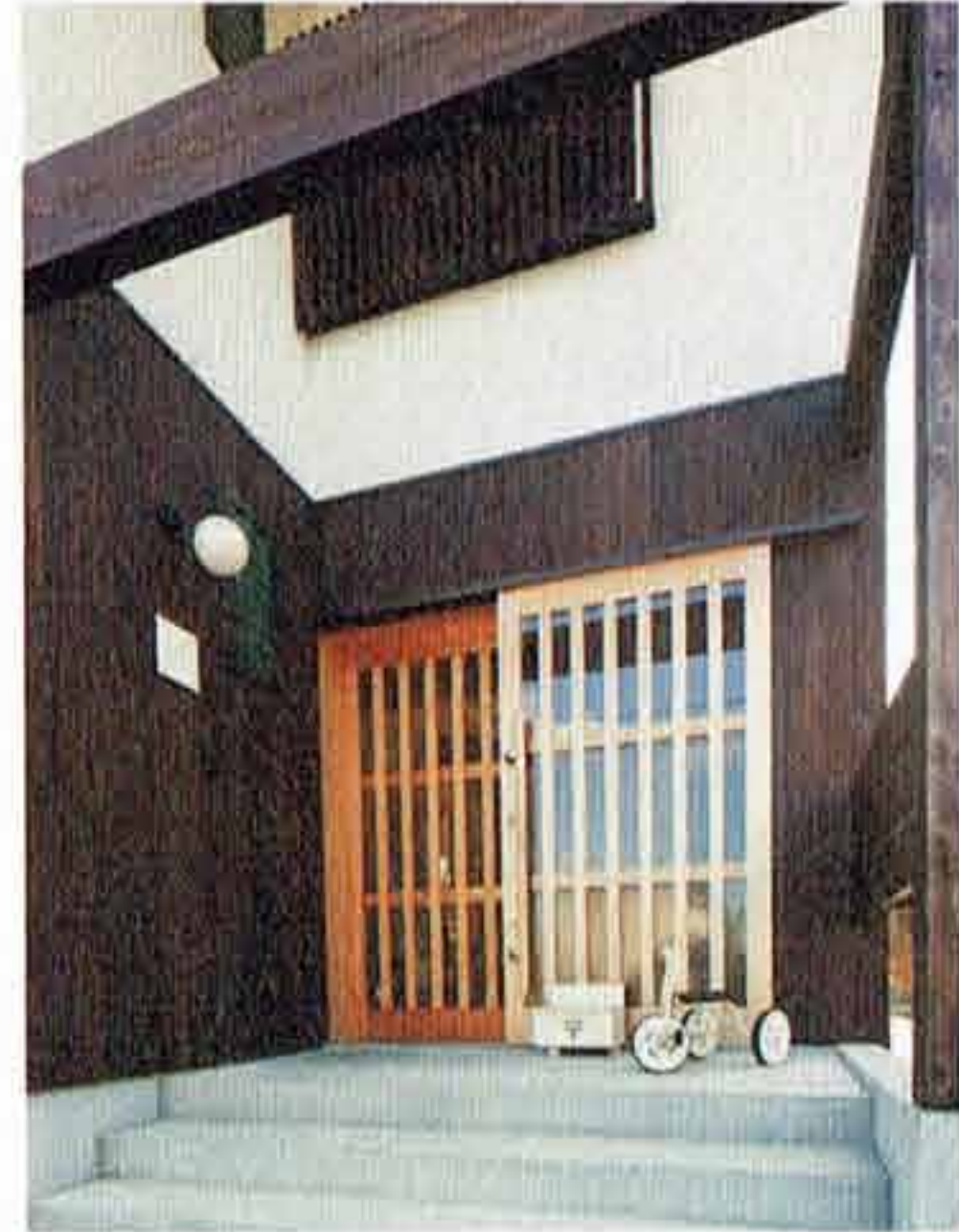
上2点/片流れ屋根の建物は南からの陽光をたっぷり取り込むつくり。吹き抜けを通して光と風、冬のストーブの暖気が家中に回り、家族の声も聞こえる。下右/木製の玄関戸は外光が入るガラスの格子戸に。下左/子供室とロフト。
